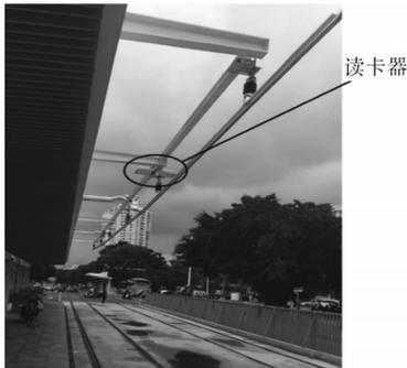
图6 RFID读卡器安装效果图
