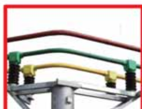
复合绝缘管形母线
