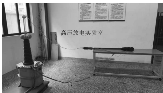
图14 35 kV欧式电缆接头实验图
