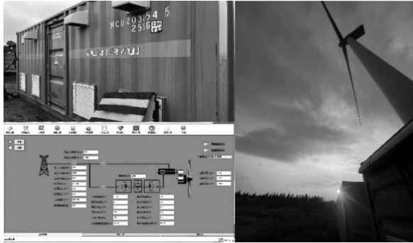
图9 电压控制型双馈风电机组现场测试照片 Fig.9 VC-DFIG field test photos
